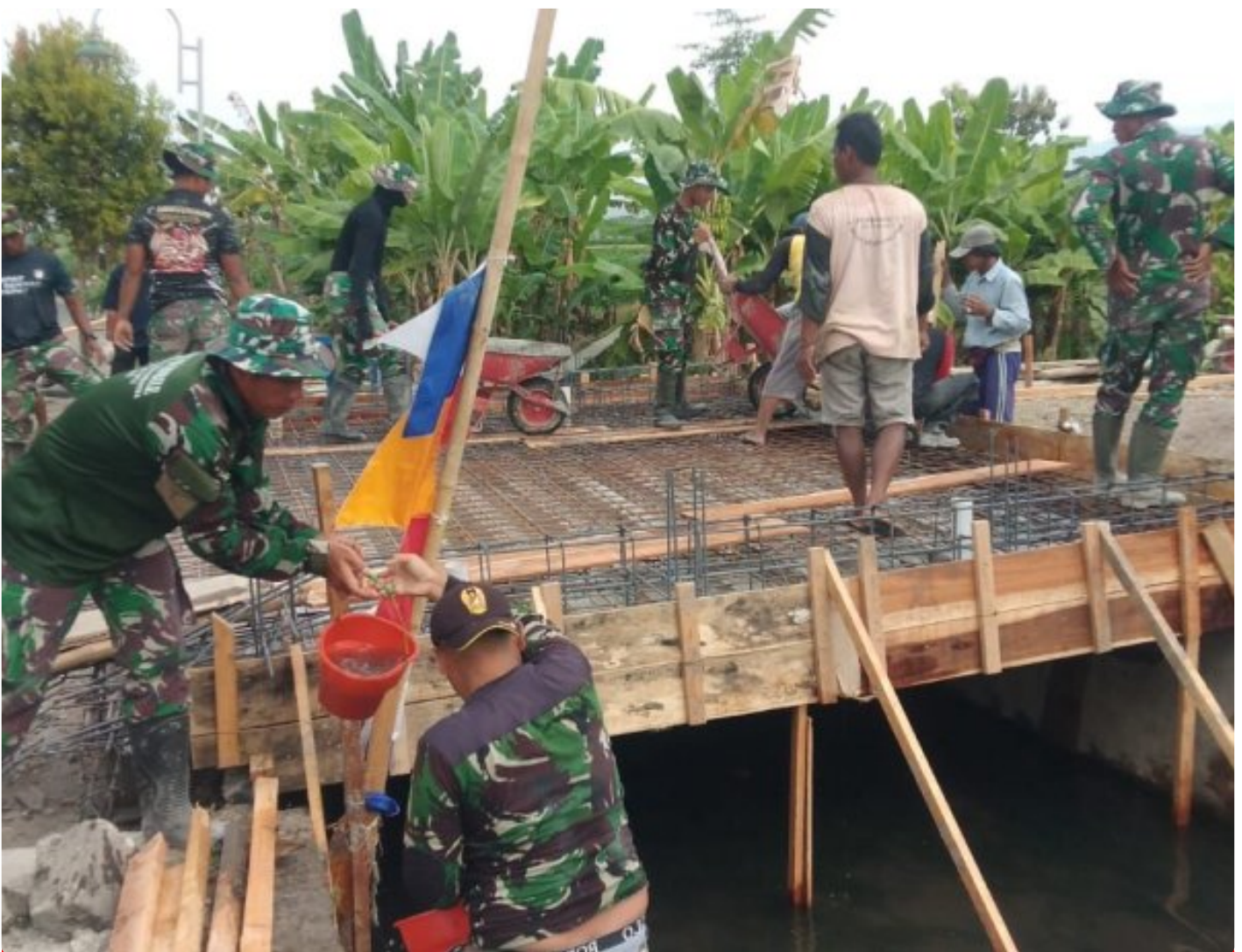
Jembatan Baru TMMD Kodim Klaten Mulai di Cor
